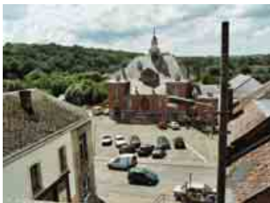
8. Vue vers la place depuis les escaliers de la rue de l'Eglise
