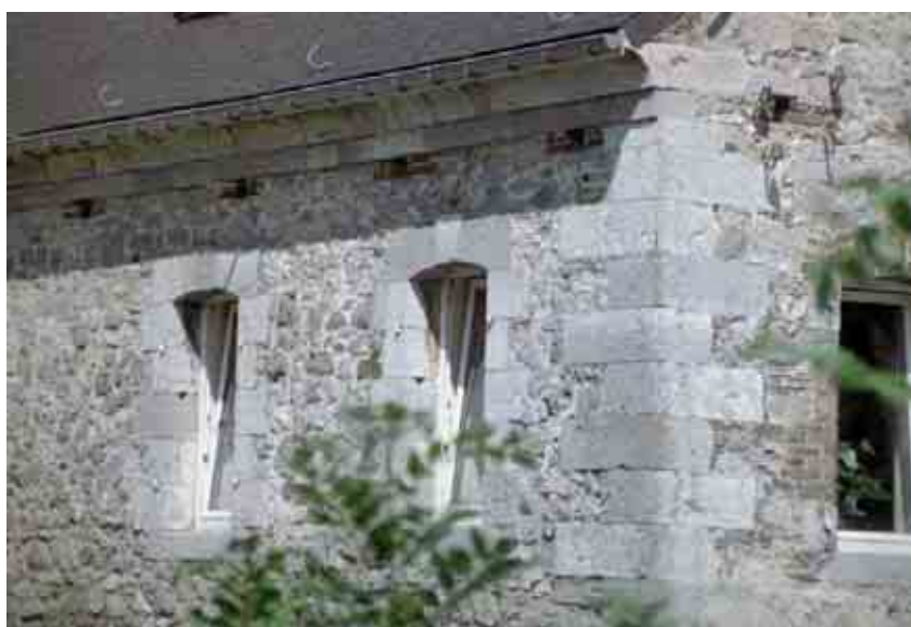
17. Détail d'un angle du bâtiment.
