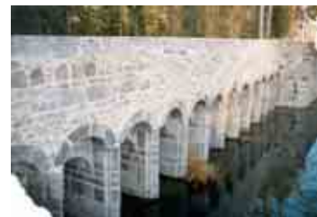
Le « pont romain » restauré (Photo M. Godeau).
