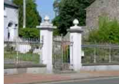
Merbes-le-Château rue Saint-Martin, n° 45
