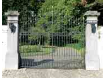
Merbes-le-Château rue Saint-Martin, n° 57
