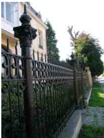
Solre-sur-Sambre rue de la Gare, n° 71
