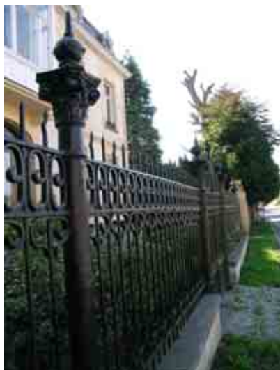
Solre-sur-Sambre rue de la Gare, n° 71
