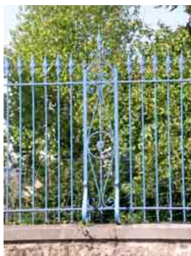
Merbes-le-Château rue Saint-Martin, n° 57
