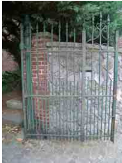
Merbes-le-Château rue Haute
