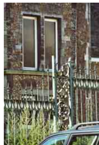
Lobbès rue de la Station, n° 17
