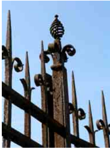
Merbes-le-Château rue Haute, n° 3
