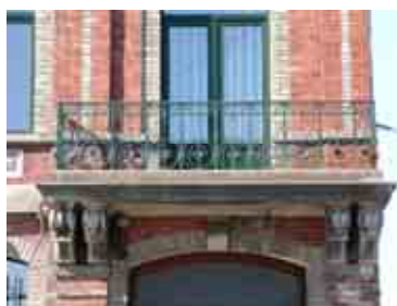
Merbes-le-Château rue Saint-Martin, n° 21
