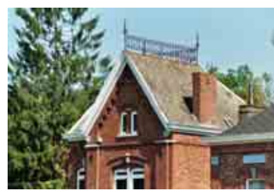
Lobbes rue du Halage, n° 14
