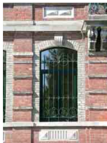
Merbes-le-Château rue Saint-Martin, n° 21
