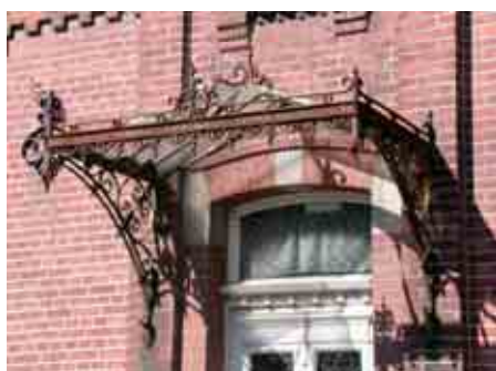
Soire-sur-Sambre rue de la Gare, n° 172
