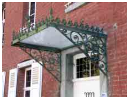
Merbes-le-Château rue Saint-Martin, n° 48
