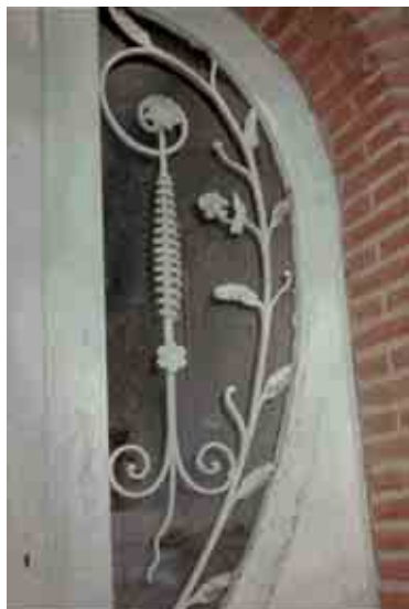
Gozée Chapelle, rue de Marbaix, n° 6
