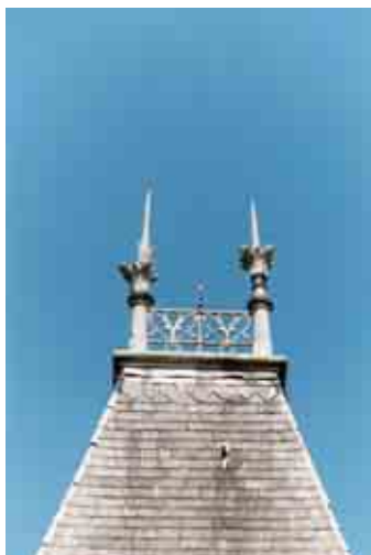
Fontaine-Valmont rue Albert, n° 4
