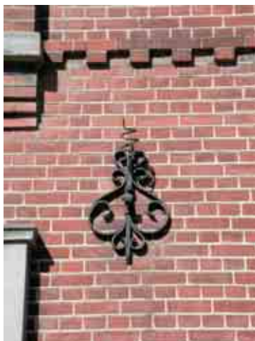
Solre-sur-Sambre rue de la Gare, n° 172
