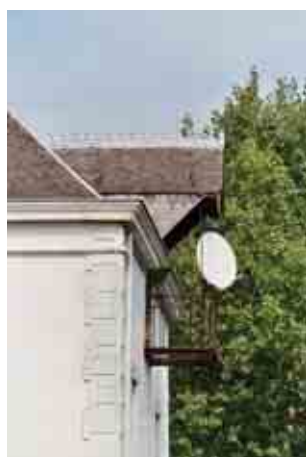
Landelies chemin de halage, fenêtre monte-charge
