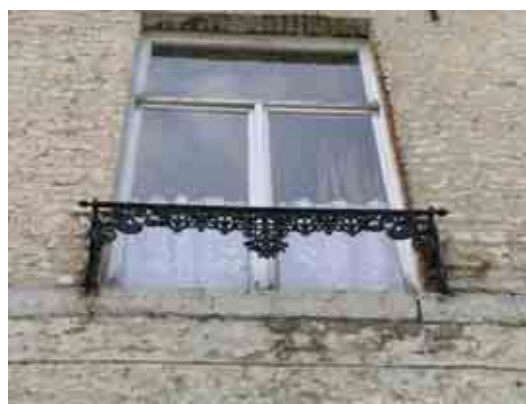
Leernes rue A. Caebergs, n° 4
