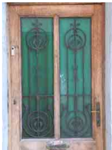
Merbes-le-Château rue Saint-Martin, porte du n° 4
